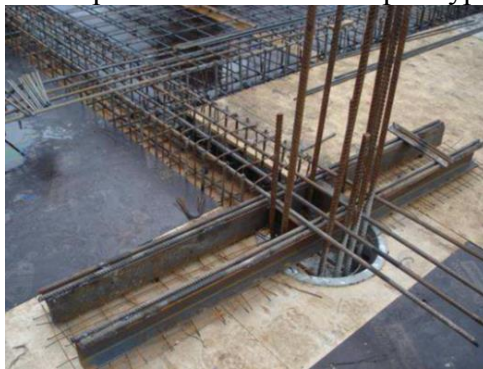
Рис. 1. Закладная деталь распределительной системы
